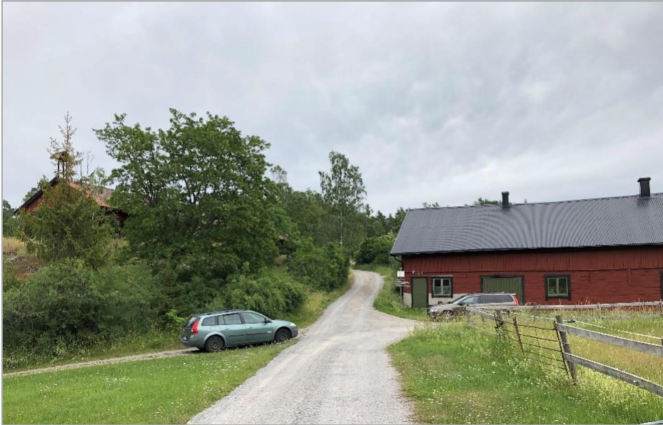
Figur 7. Stallbyggnad Långsunda 1:7 till höger, äldre ladugård av kulturhistoriskt värde skymtas på en höjd till vänster i bild.
