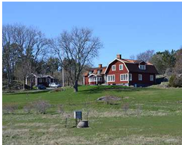
Den ursprungliga gårdsmiljön vid Bullandö är bevarad med huvudbyggnad, äldre bostadshus och flera äldre ekonomibyggnader.
