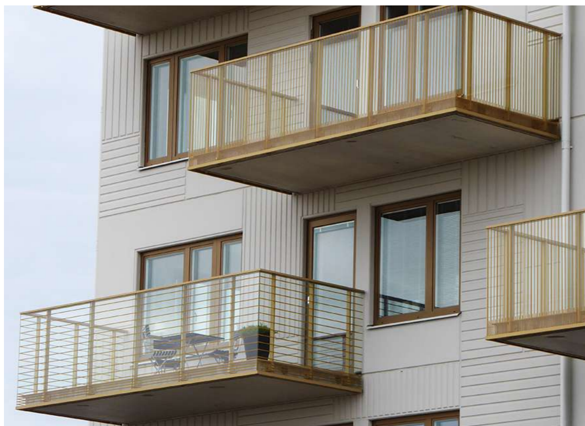
Balkonger med screentryckt pinnräcke Foto: Arqdesign - VISION Glas 1100
