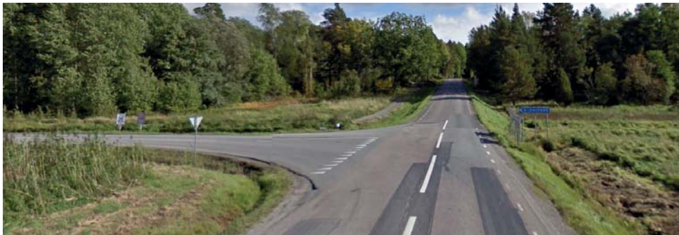
Figur 2-5 Korsningen Fagerdalavägen/Saltarövägen. Fagerdalavägen smalnar av och mittmarkeringen upphör öster om korsningen. Bildkälla: Google Maps
