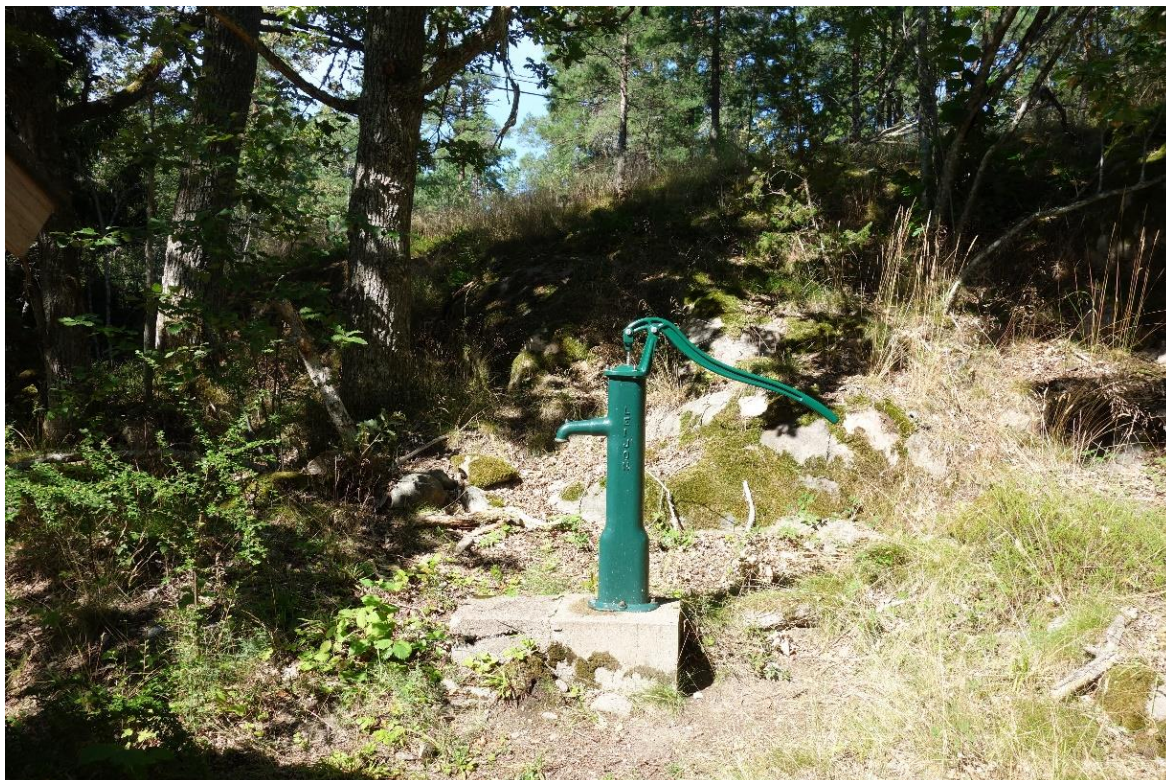
Figur 3.8.4 Gemensam äldre handpump. Brunnen konstruerad i sandig morän men troligtvis borrar ner i berg.
