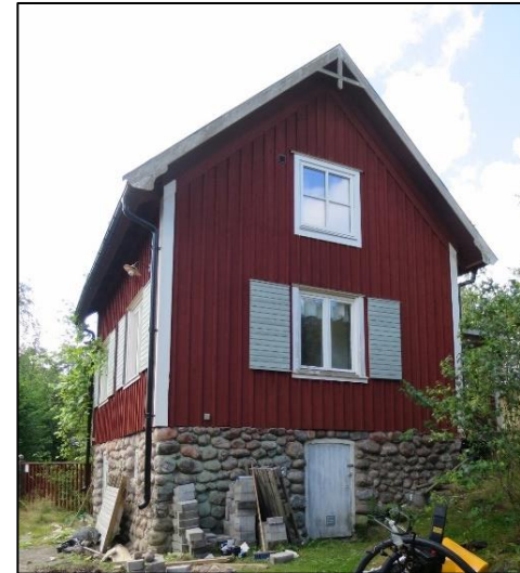
Figur 40. "11:an" -det sista huset i området uppfört av Johan Hållstedt. På senare tid har moderna fönster monterats på övervåningen.
