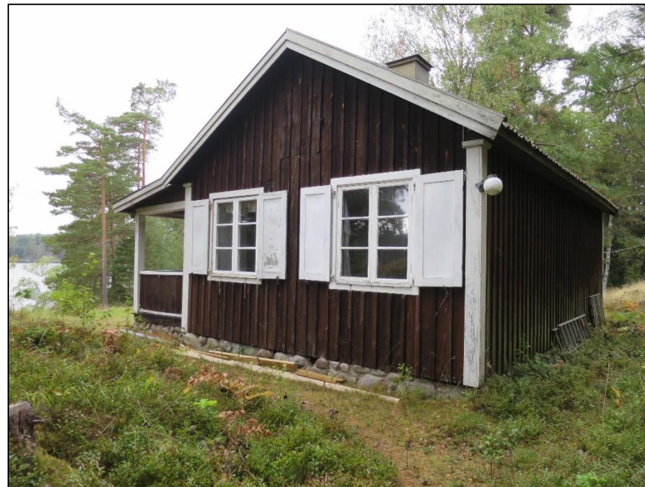
Figur 52. Fasad mot öster.
