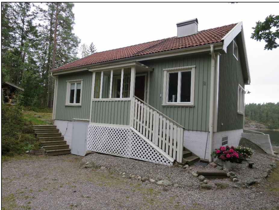
Figur 30. Säby 1:93. Slammad hålstenssockel. Stående locklistpanel. Fönster med listverk, droppnäsor och krönlister. Flerkupigt taktegel.
