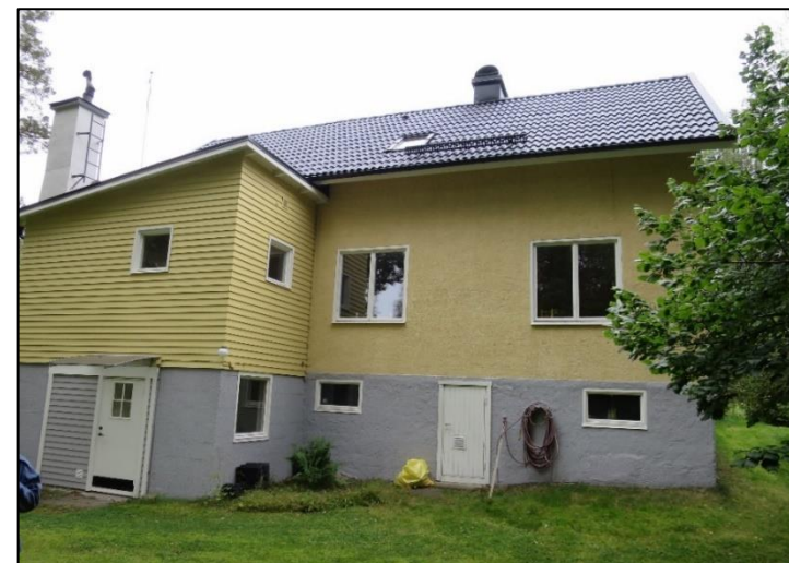
Figur 43. Baksidan, vänd mot landsvägen, med tillbygge.
