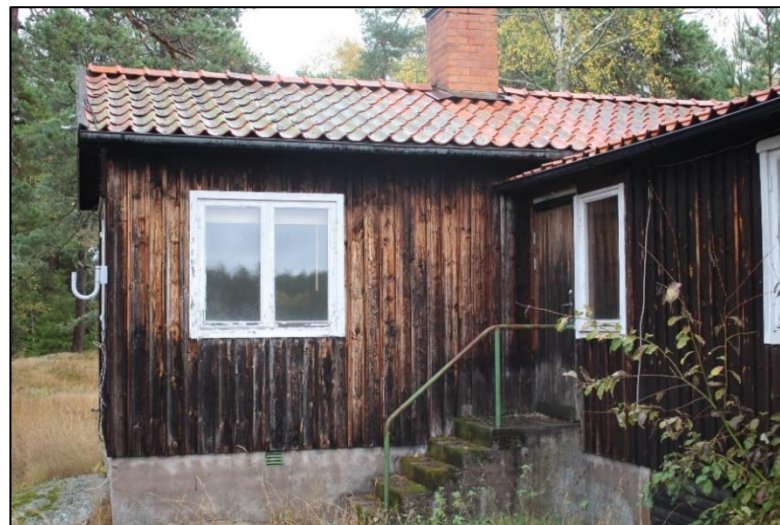
Figur 68. Gjuten trappa med enkelt räcke i rundstål.
