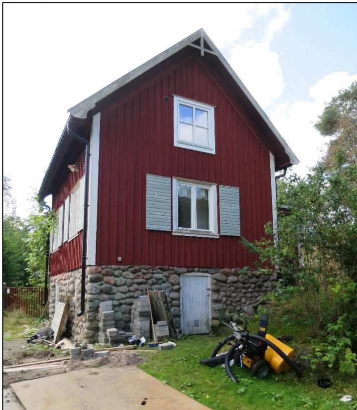
Figur 28. Säby 1:137. Terränganpassad sockel med inmurad, exponerad fältsten. Stående locklistpanel. Färgsättning rött med vita knutar, tvåluftsfönster med listverk, droppnäsor och krönlister. Vindskivor med områdesspecifikt utförd utsmyckning i ändarna. Flerkupigt taktegel.
