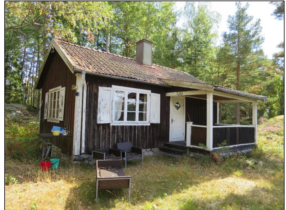
Figur 51. Fasad mot vattnet.
