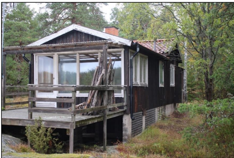
Figur 66. Stolpuppbyggnad mot vattnet.
