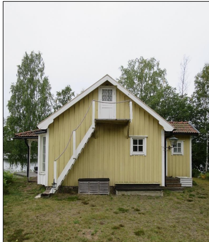
Figur 29. Säby 1:55. Stående locklistpanel, genomarbetade snickerier i form av glasad fyllningspaneldörr samt fönster med listverk, droppnäsor och krönlister. Vindskivor med områdesspecifikt utsmyckning. Sammansatt tak med flerkupigt tegel.
