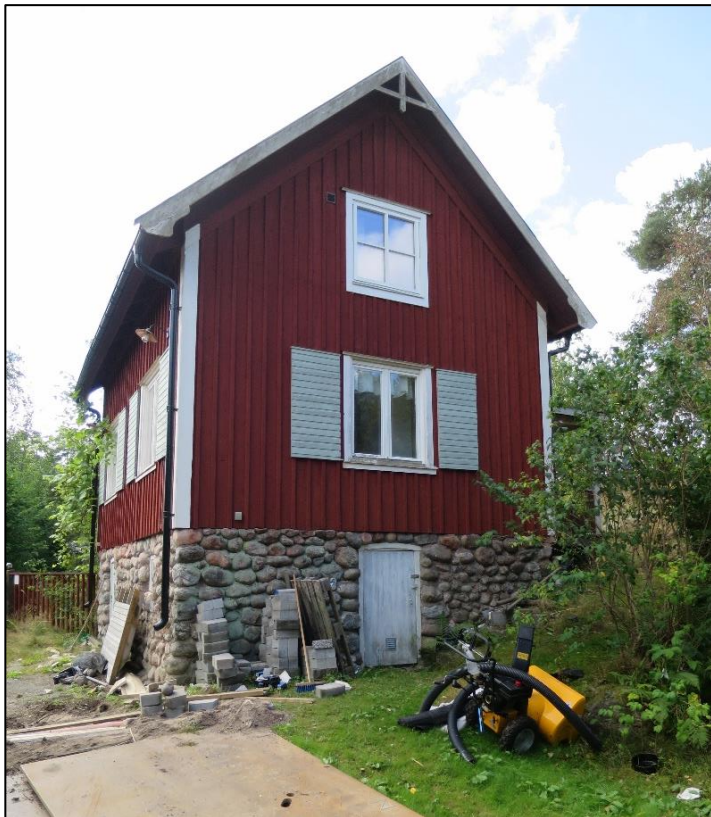
Figur 27. Säby 1:137. Terränganpassad sockel med inmurad, exponerad fältsten. Stående locklistpanel. Färgsättning rött med vita knutar, tvåluftsfönster med listverk, droppnäsor och krönlister. Vindskivor med områdesspecifikt utförd utsmyckning i ändarna. Flerkupigt taktegel.
