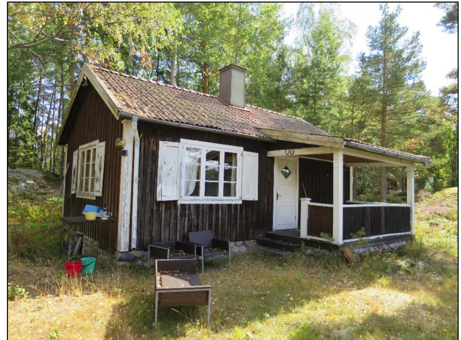
Figur 50. Fasad mot vattnet.
