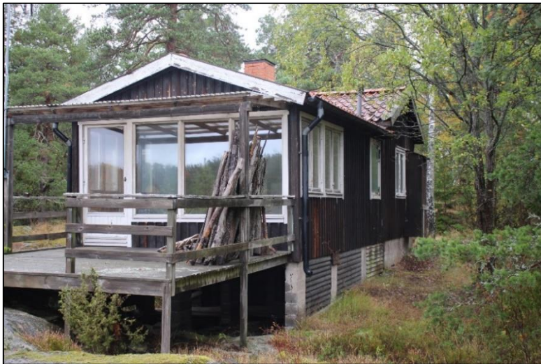
Figur 63. Stolpuppbyggnad mot vattnet.
