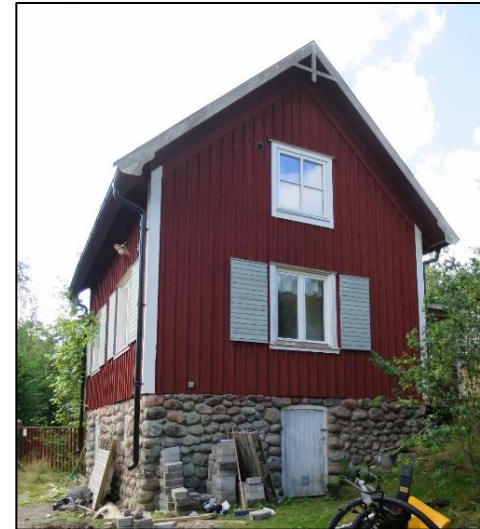
Figur 39. "11:an" -det sista huset i området uppfört av Johan Hållstedt. På senare tid har moderna fönster monterats på övervåningen.
