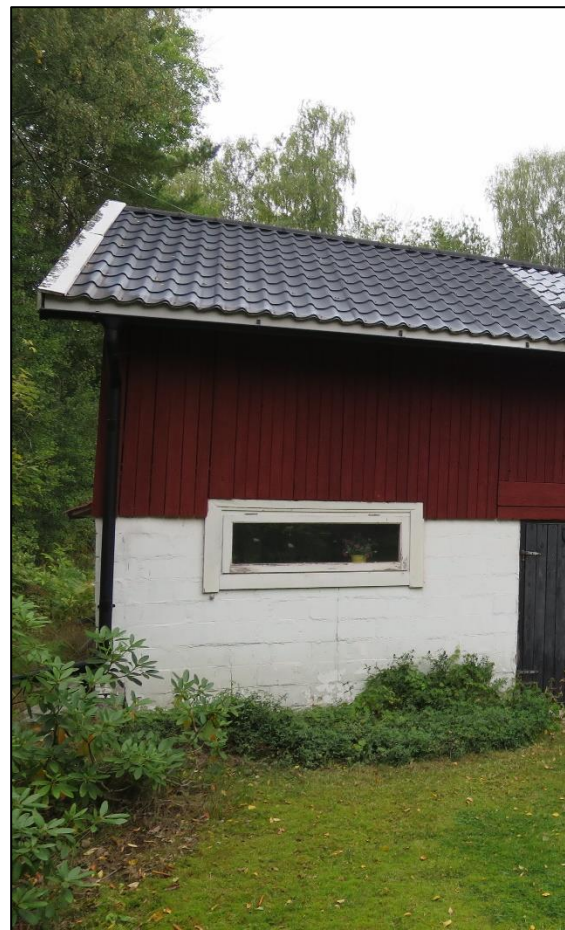
Figur 30. Säby 1:138. Slammad hålstenssockel.
