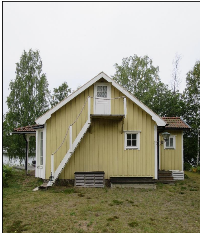
Figur 28. Säby 1:55. Stående locklistpanel, genomarbetade snickerier i form av glasad fyllningspaneldörr samt fönster med listverk, droppnäsor och krönlister. Vindskivor med områdesspecifikt utsmyckning. Sammansatt tak med flerkupigt tegel.
