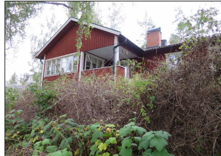
Figur 36, 37. Byggnaden ligger fint inordnad i ett sluttande läge.
