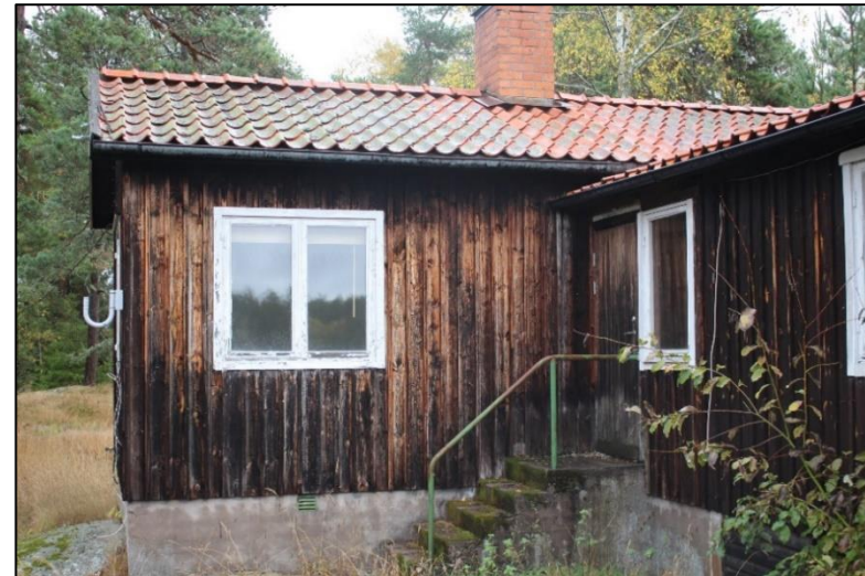
Figur 65. Gjuten trappa med enkelt räcke i rundstål:
