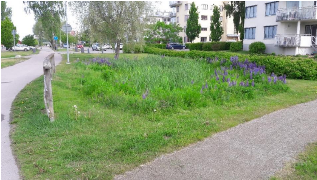
Figur 14. Större nedsänkt grönyta för hantering av dagvatten från anslutande ytor. Vatten leds in till bädden via markavrinning på bred front då anslutande ytor skevas mot bädden.
