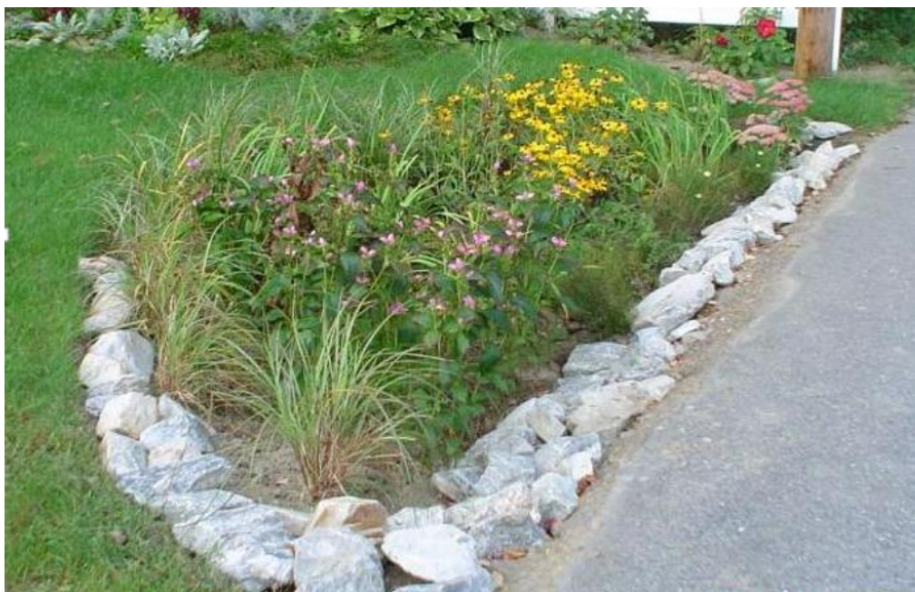
Figur 12. Nedsänkt växtfilterbädd för hantering av dagvatten. Kanter som anläggs med stenkross kan motverka erosion speciellt om vatten tillåts flöda in i bädden på bred front.
