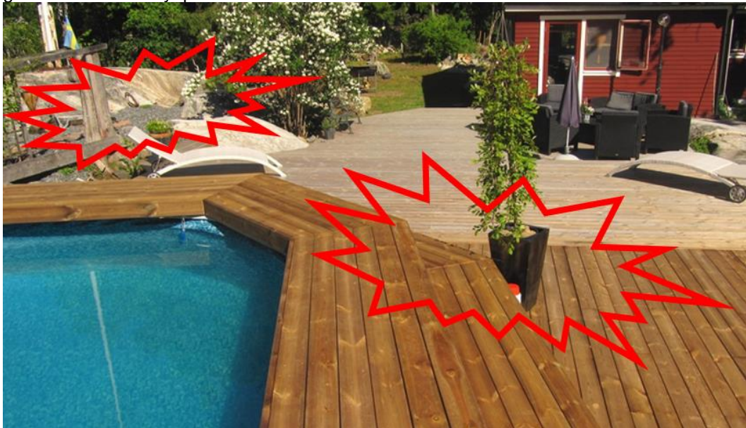
Figur 25 Exempel på hur det inte ska se ut. Stor träaltan minskar möjligheten för infiltration, krukväxter behöver bevattnas och berget är rensat på jordlager vilket ökar avrinningen.
