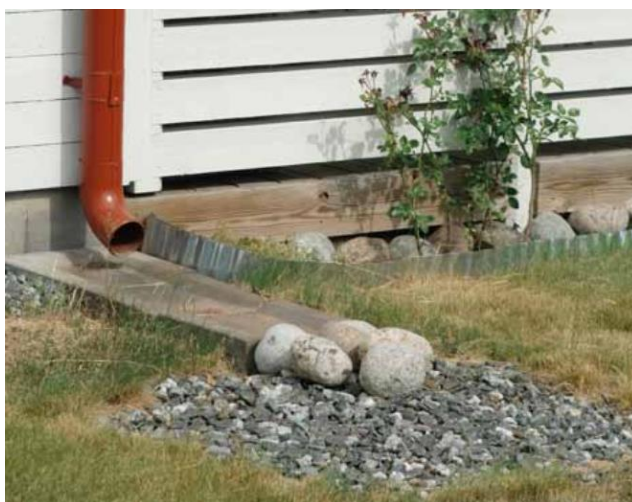
Figur 27 Takvatten leds från stuprännan bort från husgrund mot ett erosionskydd och vidare ner i makadambädd där infiltrering kan ske.
