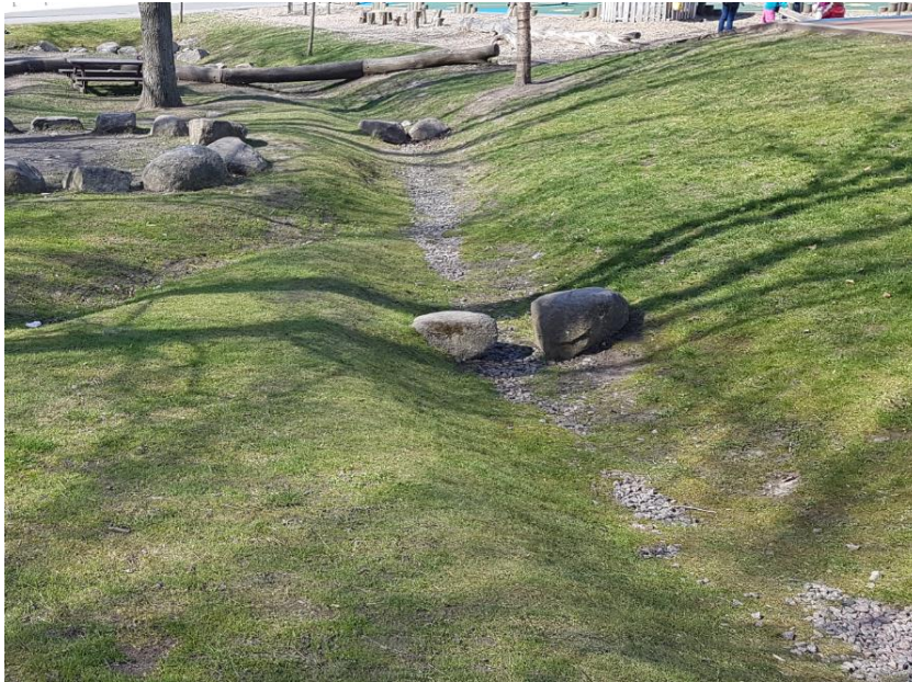
Figur 29 Dike med makadam i botten samt stenläggning som ytterligare fördröjer vid höga flöden.
