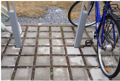
Figur 22 Genomsläppliga fogar mellan gatsten samt fördröjd avrinning via makadam. Figur 23 Parkering med gräsarmering.
