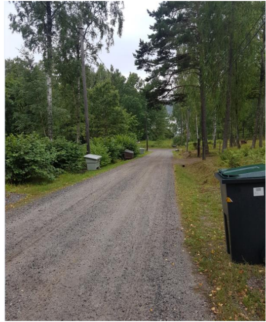
Figur 10 Lokalväg med grunt dike.
