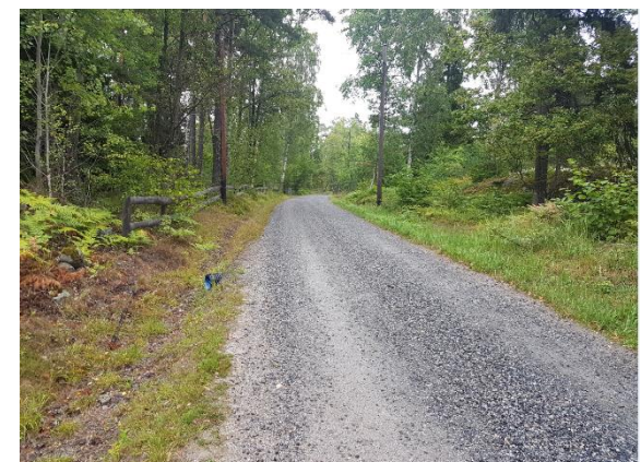
Figur 14 Dike längs med väg.
