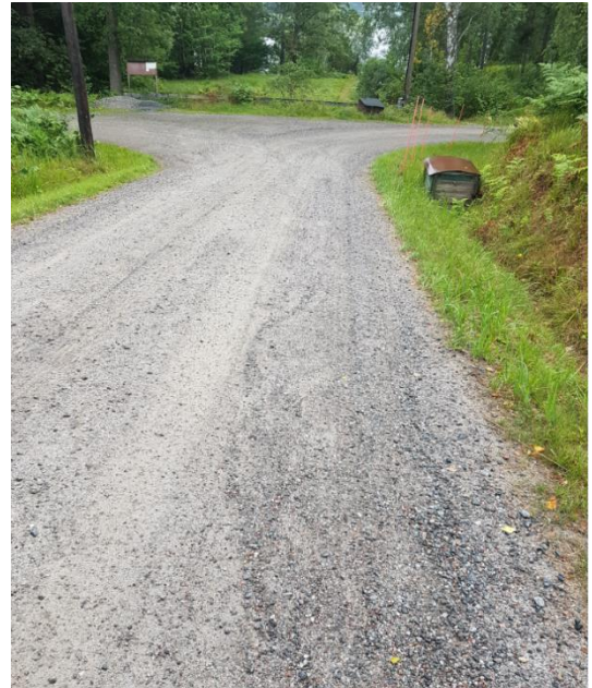
Figur 12 Dike längs med väg med rännilar på grusväg.
