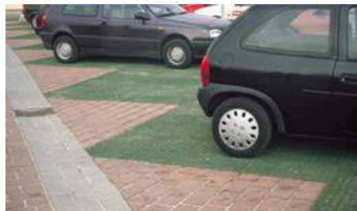
Figur 22 Genomsläppliga fogar mellan gatsten samt fördröjd avrinning via makadam. Figur 23 Parkering med gräsarmering.
