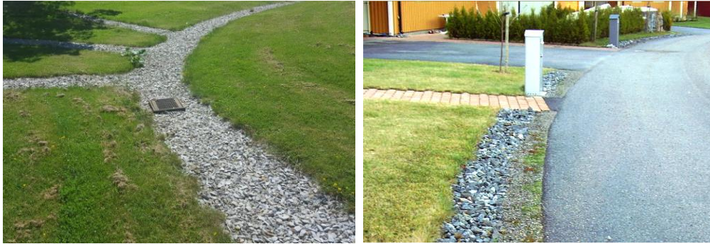
Figur 23. Exempel på krossdiken. Källa: Ramboll, 2016 och SVOA, u.d.
