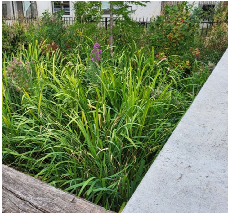
Bilden ovan visar ett biofilter i form av en plantering i ett bostadskvarter i Köpenhamn.
