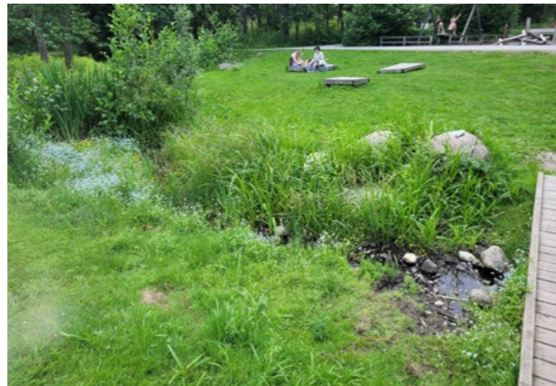
Nedsänkta grönytor renar och fördröjer vattnet innan det når dagvattenledningen.
