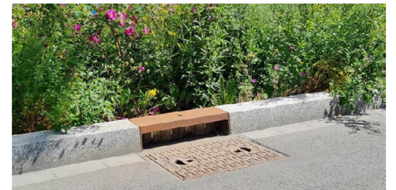
Bilden ovan visar ett regnbäddslås KerbCells™ från Milford som kan reglera vattenflödet in i regnbädden under de månader då vägarna saltas. (Milford)
