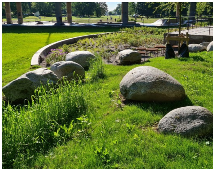
Bilden ovan visar ett biofilter i Rålambshovsparken, Stockholm, både för rening av dagvatten och som fördröjningsmagasin vid kraftiga regn.
