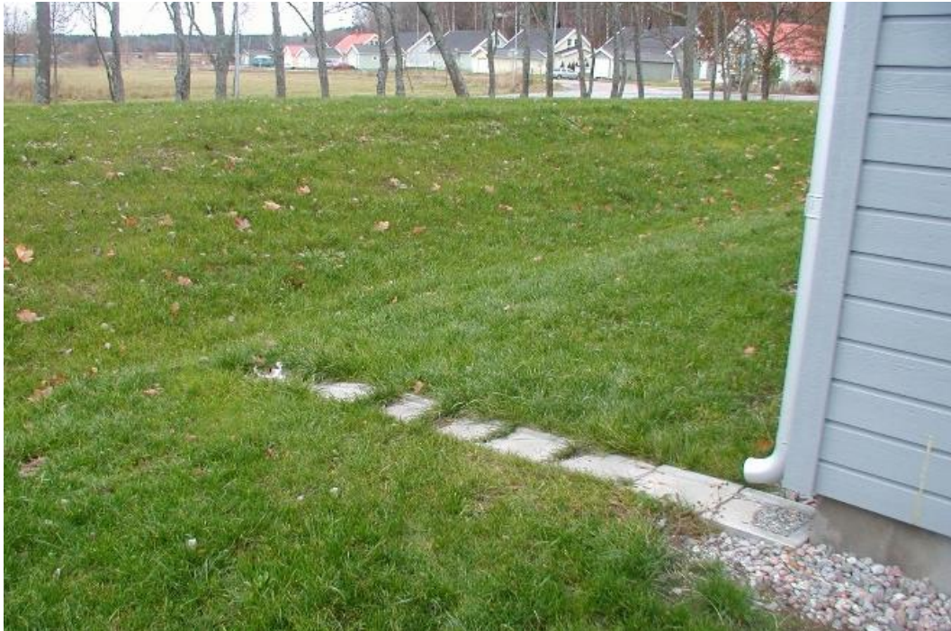
Figur 8. Exempel på takvatten som avleds via utkastare och rännal till mindre gräsmatta vidare mot lågområde. Notera att marken sluttar bort från husen. Foto: WRS.
