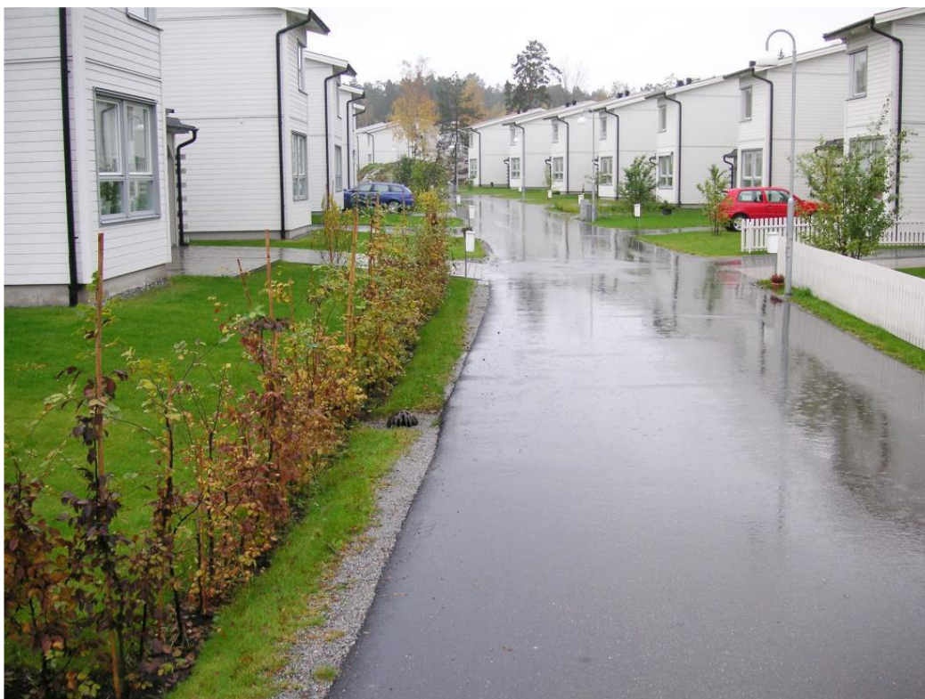
Figur 12. Exempel på makadamdike utmed lokalgatan Kvarndammsringen i Charlottenda, Värmdö. I diket finns kupolbrunnar på några ställen som ansluter till dräneringsledningen för att hantera höga flöden. Foto: WRS.
