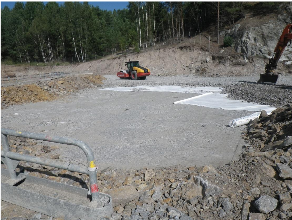
Figur 6. Installation av markavskiljningsduk inom det område där föroreningar har lämnats kvar. Innan duken lades ut jämnades schaktbotten till. Omgivande markytor har även jämnats till.
