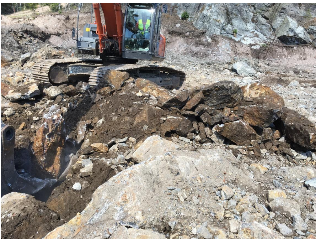
Figur 4. En stor del av massorna inom tippområdet utgjordes av block och sprängsten. I bilden pågår provgrävning för provtagning och klassificering av SEV-ruta C9.
