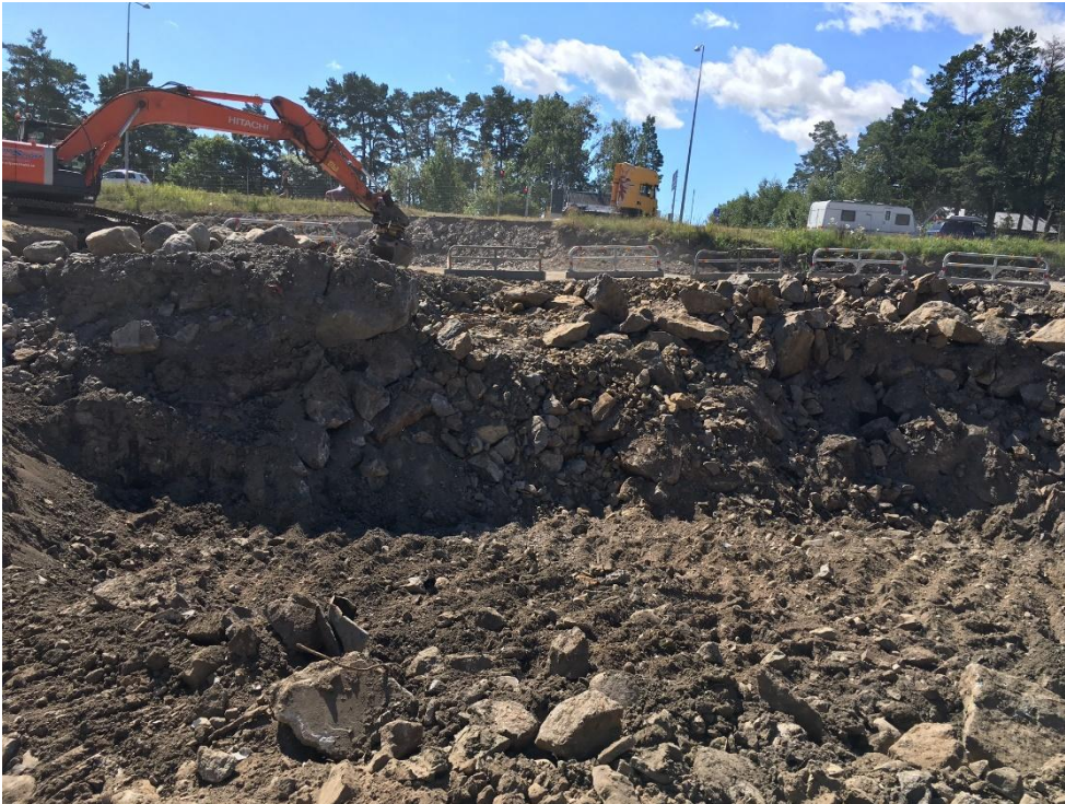
Figur 5. Sanering och provtagning i schaktväggar och -botten i SEV-ruta C9.
