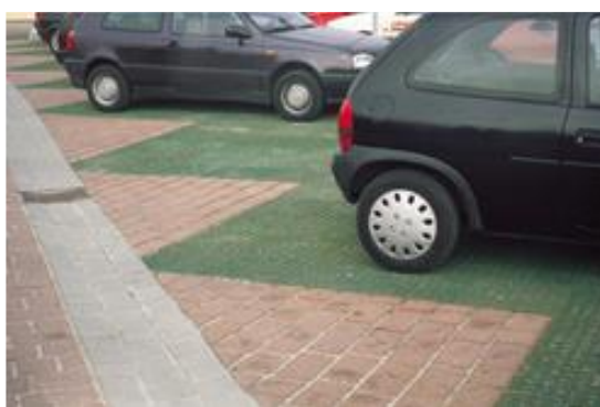
Figur 51: Parkering med gräsarmering.
