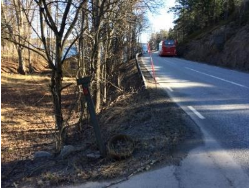
Figur 83: Vid fastighet Fågelbro 46:1 vid Väg 222 har flera avkörningsolyckor inträffat. Dubbla skyddsräcken skulle öka säkerheten.
