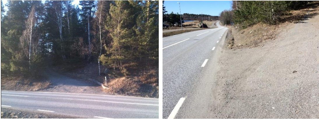
Figur 60: Bilderna visar statlig väg 222 där inga nya utfarter tillåts utan Trafikverkets godkännande. Endast befintliga enskilda utfarter kan användas och utvecklas.
