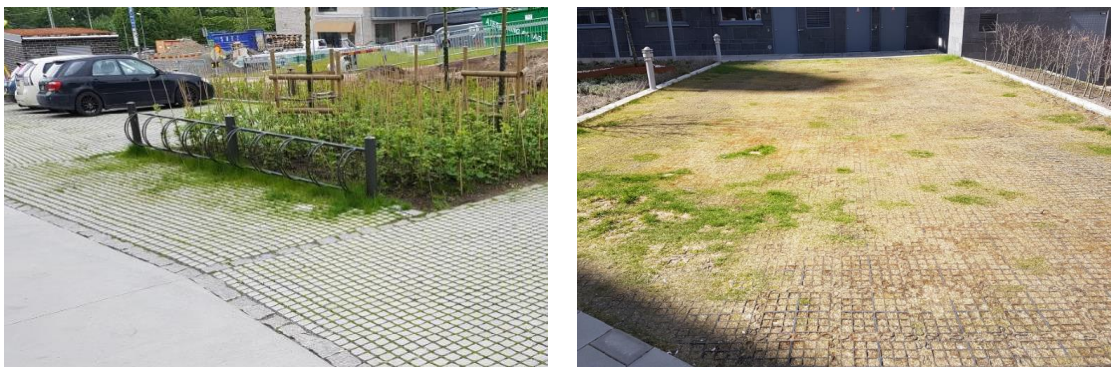
Figur 14. Exempel på genomsläpplig beläggning som alternativ till helt hårdgjord yta vilka minskar avrinningen.
