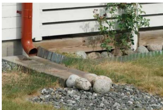
Figur 15. Till vänster, makadamdike i trädgård och till höger stuprörsutkastare med rännal och erosionsskydd avleder takvattnet ut till grönyta.
