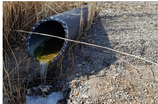
Figur 9. Utlopp 4 är beläget utanför planområdet i söder. Delområde 7 avrinner till detta utlopp. Vattnet rinner ur ledning direkt ut i recipient utan rening i t.ex. vass.
