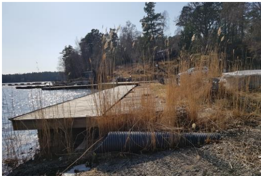
Figur 9. Utlopp 4 är beläget utanför planområdet i söder. Delområde 7 avrinner till detta utlopp. Vattnet rinner ur ledning direkt ut i recipient utan rening i t.ex. vass.
