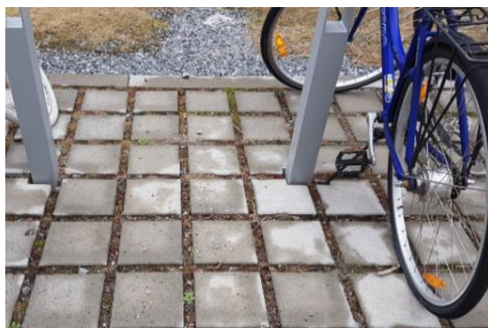
Figur 16. Till vänster, Plantering (växtbädd) i trädgårdsmiljö dit avrinning leds via rännal av makadam. Till höger, gatsten med genomsläppliga fogar, ett alternativ till helt hårdjord yta.
