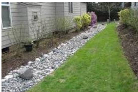
Figur 15. Till vänster, makadamdike i trädgård och till höger stuprörsutkastare med rännal och erosionsskydd avleder takvattnet ut till grönyta.
