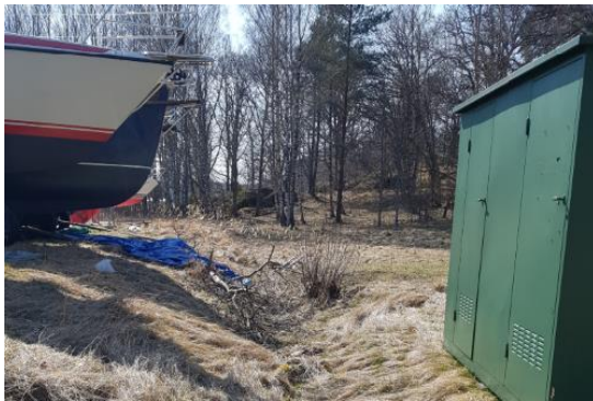
Figur 8. Avskärmande dike intill båtuppläggningsplats vid utlopp 3 (t.v.). Båtar uppställda på presenning vilket minskar risk för spridning av t.ex. miljöskadliga ämnen i gammal båtbottnfärg.
