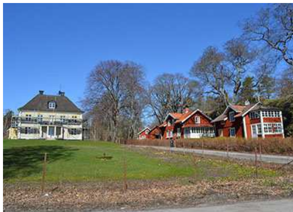
Fagerdalas mangårdsbyggnaden från 1860 och arbetarbostäderna placerade på rad utefter vägen.
