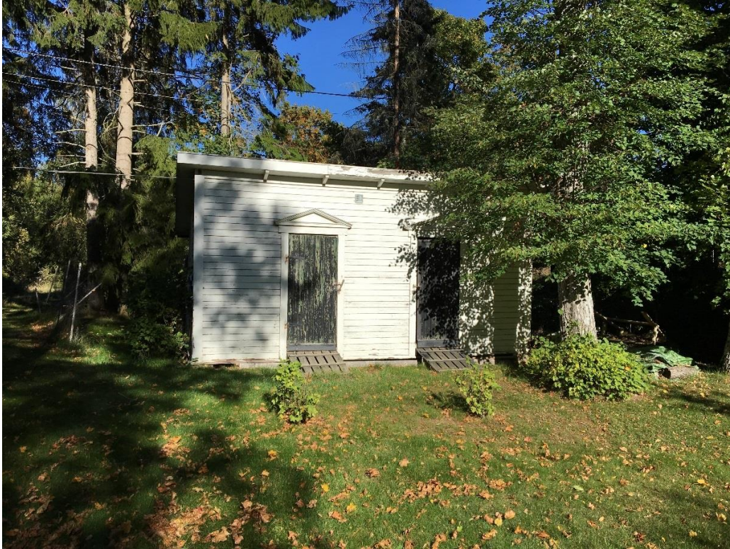
Uthusets södra fasad.
