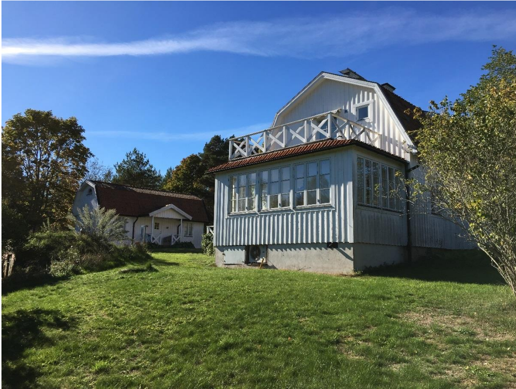
Byggnad 19 sett från nordost med byggnad 20 i bakgrunden.
