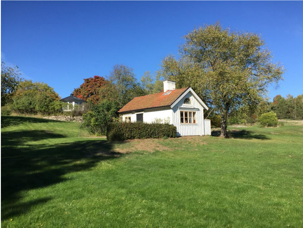
Byggnad 9 sett från väst med lusthuset i bakgrunden.
