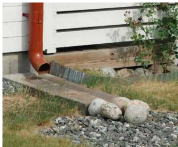
Figur 14. Till vänster visas regntunnor för uppsamling av takvatten och till höger stuprörsutkastare med rännal och erosionsskydd avleder takvattnet ut till grönyta.
