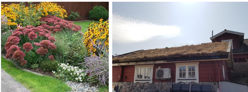
Figur 15. Till vänster, Plantering (växtbädd) i trädgårdsmiljö dit avrinning leds via rännal av makadam. Till höger, exempel på grönt tak från planområdet.
