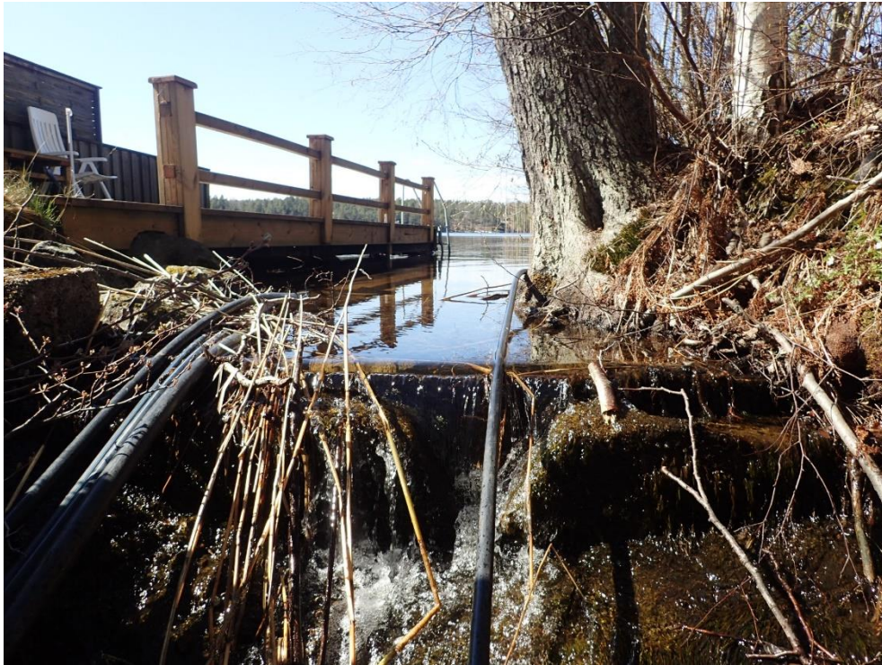
Figur 3: Bild över dagens dammtröskel.
