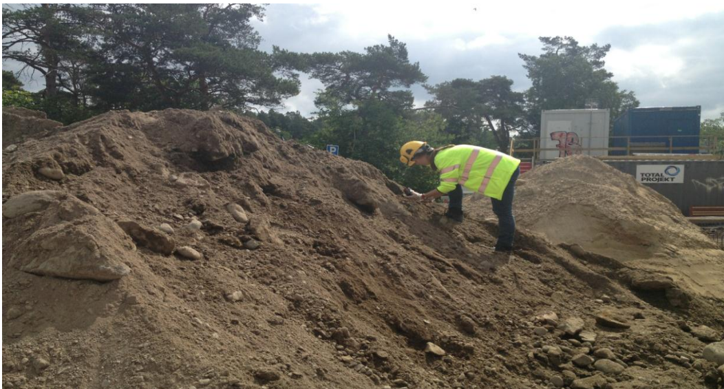
Figur 8. Provtagning ur hög med uppschaktade massor. (källa: Geoveta 2012, provtagning mark, avseende föroreningar Gustavsberg 2:5).
