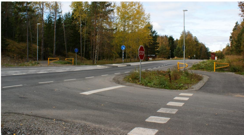
Osäker passage över väg 222 Stavsnäsvägen med 70km/h och passage över Grävlingstigen
