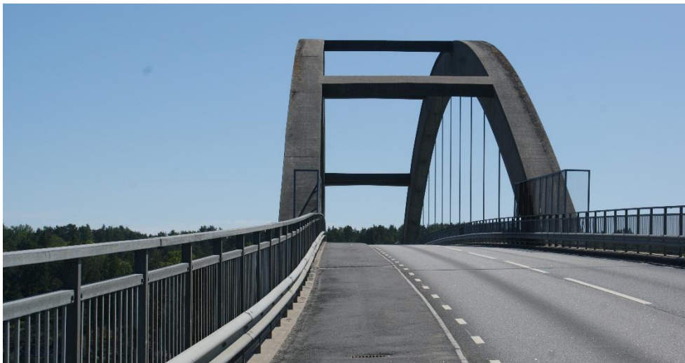
Gång- och cykelväg över Djuröbron
