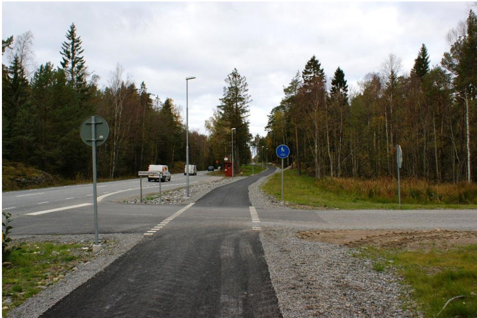
Nybyggd kommunal GC Strömma-Ålstäket vid Rödingstigen. Vägen bör förses med mittlinje och cykelmyror
