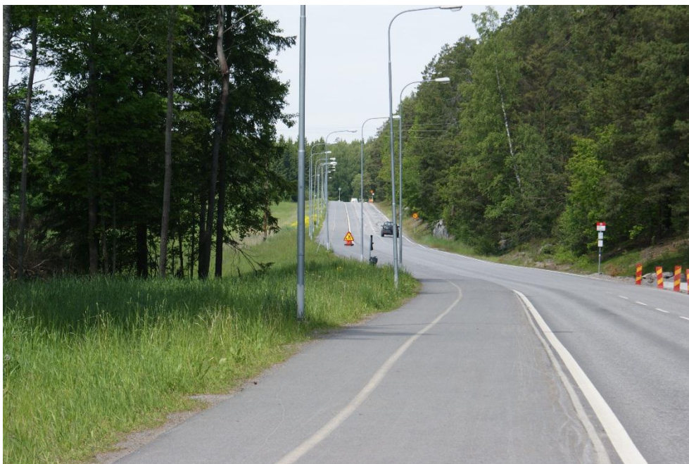
Kommunal GC med heldragen vit linje som bör kompletteras med ny mittlinje och cykelmyror
