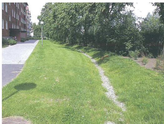
Figur 9 Infiltration av dagvatten till svackdike.
