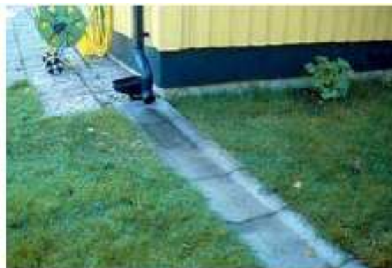
Figur 4: Detalj av stuprörsutkastare och rännalsplattor.
