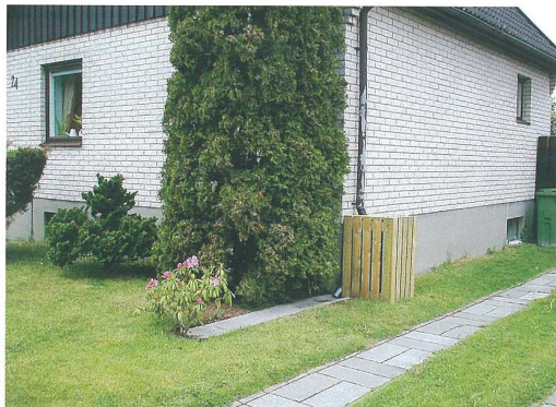
Figur 3: Infiltration av takdagvatten på tomtmark.
