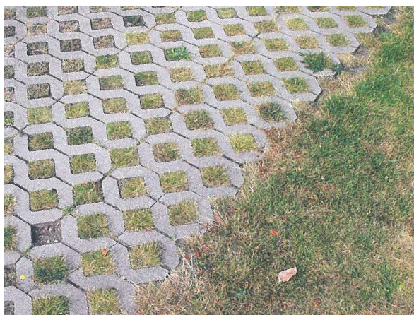
Figur 8 Parkeringsyta med hålsten av betong.
